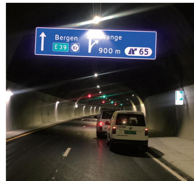
挪威海底隧道项目
