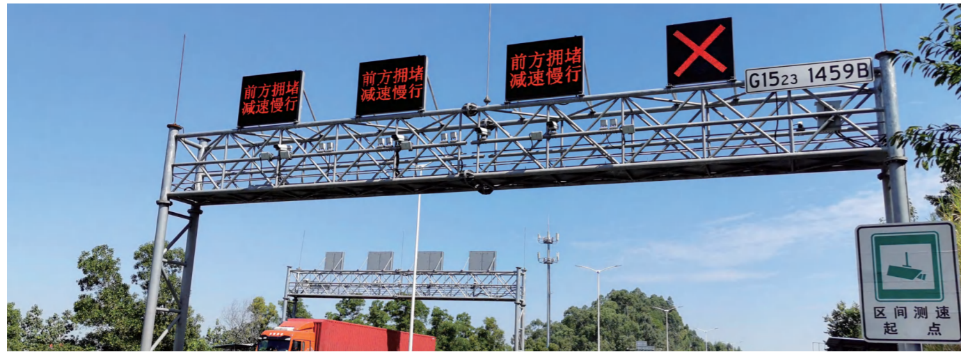
■ 东莞莞深高速项目
