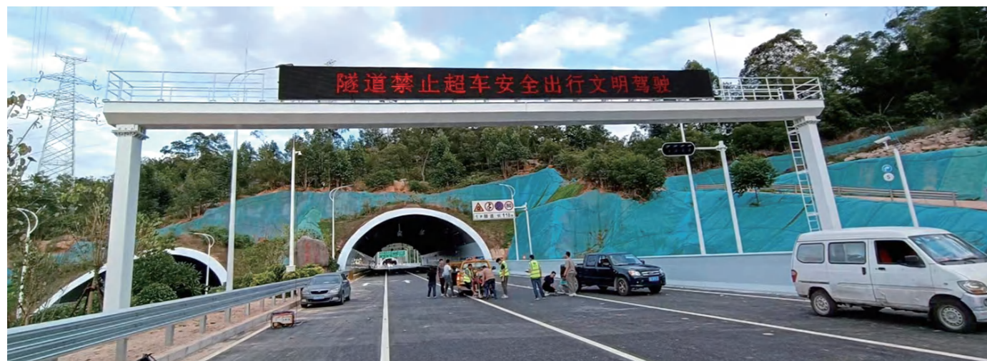
■ 厦门疏港通道项目
