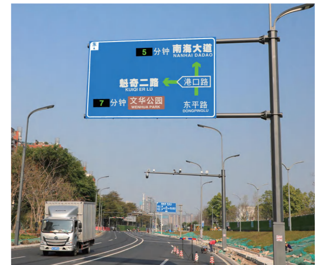
佛山东平路智慧道路项目(智慧灯杆、车路协同)
